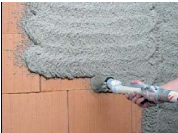
Bild 14: Auftrag des Unterputzes auf Planziegelmauerwerk
